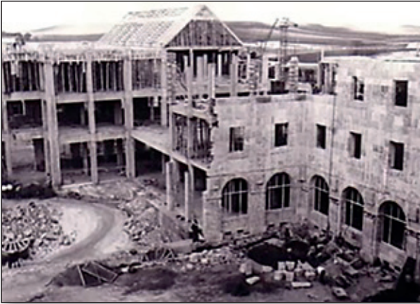
Obras del Colegio (1955-1957).
