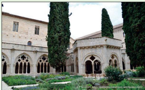
Arquería de la crujía occidental, ya góticas y templete del lavatorio.
