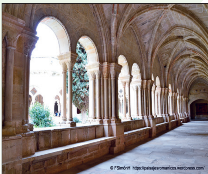
Arquería de la crujía sur del claustro.
