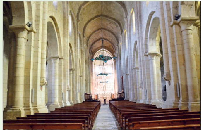
Nave central desde los pies y cubierta de la nave central.
