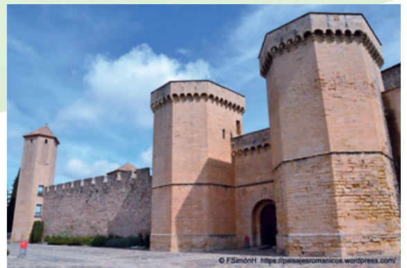
La Puerta Real, entrada al recinto claustral entre dos torres.
